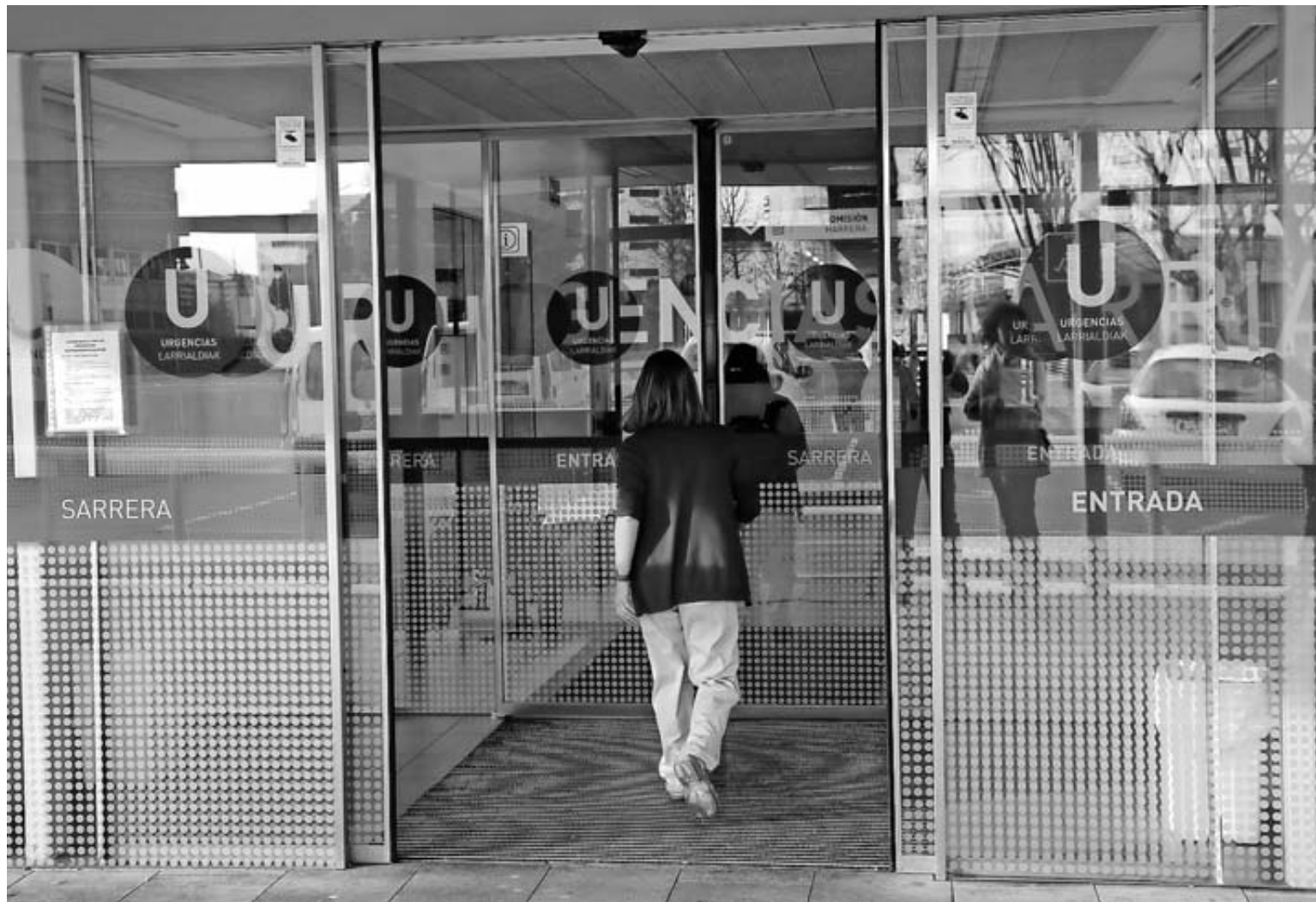
Entrada al edificio de Urgencias del Complejo Hospitalario de Navarra.
