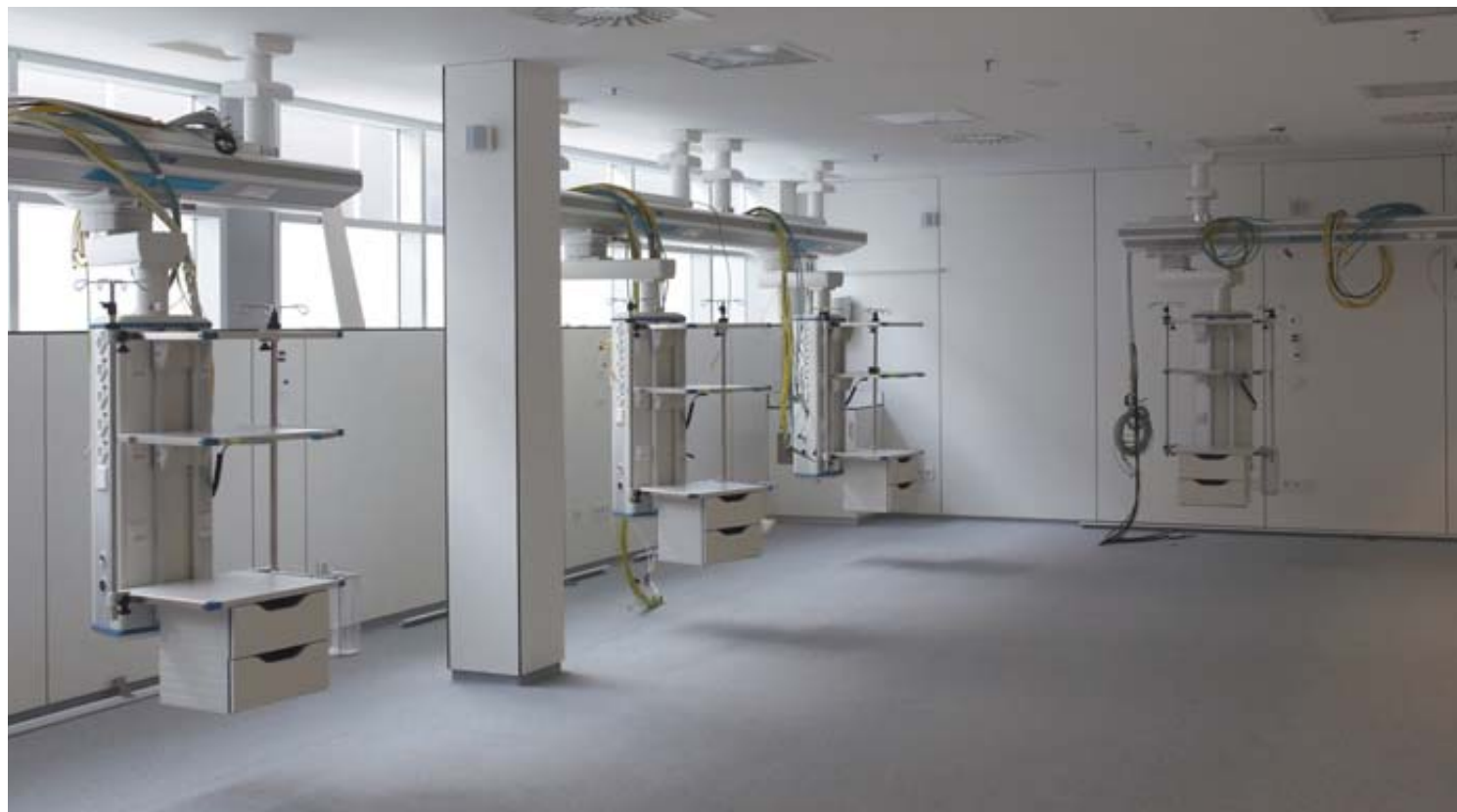
Imagen de la sala donde se ubicará la nueva UCI pediátrica.
