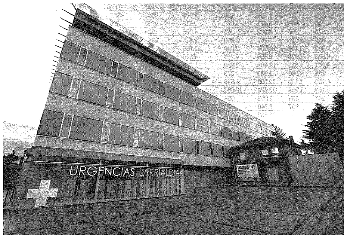
Nuevo edificio de urgencias del Complejo Hospitalario de Navarra.
