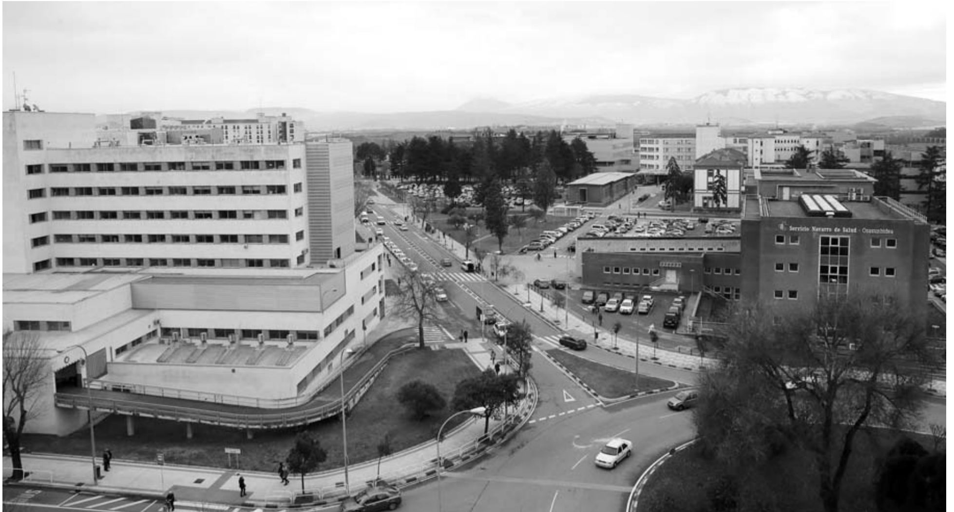
Vista general de la zona hospitalaria, con Virgen del Camino (izquierda), centro de consultas Príncipe de Viana (derecha) y Hospital de Navarra (fondo).
