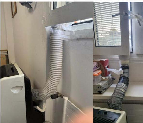
En el CCI y en otros locales se han repartido “pingüinos” para reducir la temperatura. Estos aparatos captan el aire ambiente, lo enfrían y emiten frontalmente un chorro de aire frío y evacuan el aire caliente a través de un tubo corrugado que debe tener salida al exterior. Y tal como se aprecia en las fotografías, el tubo se coloca sujeto con esparadrapos en la ventana que se mantiene entreabierta. La medida efectivamente reduce la temperatura del habitáculo, pero resulta muy poco
